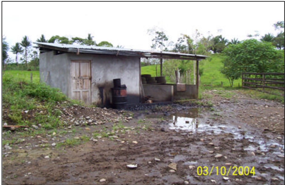
Fotografía 1. Caseta y tanque de aceite quemado
