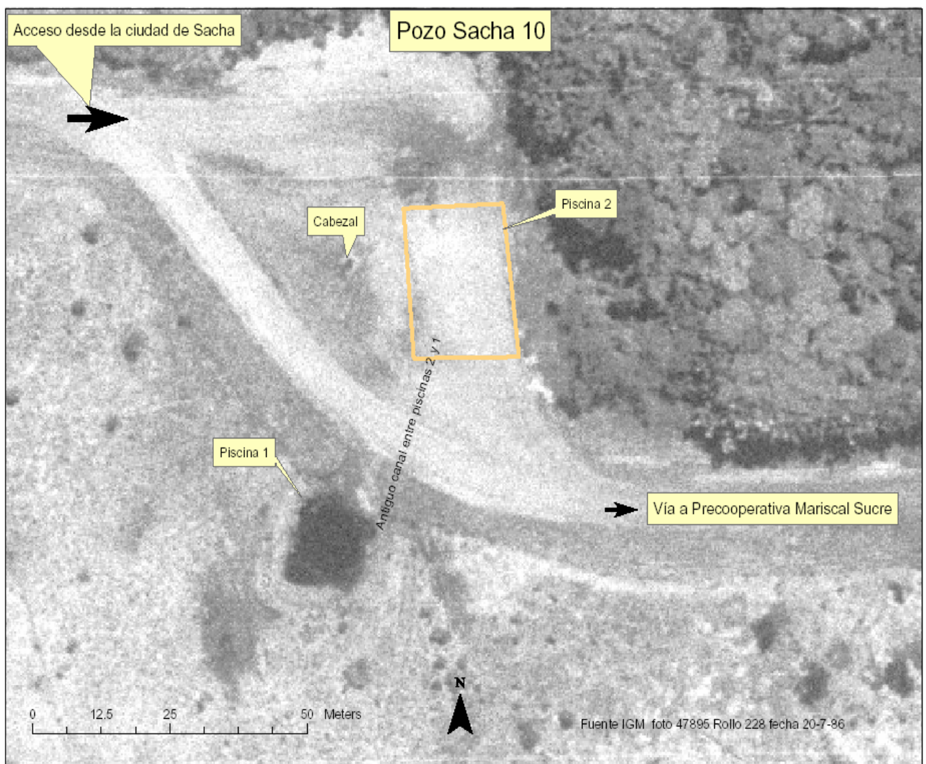
Fotografía 7. Toma aérea de las piscinas 1 y 2 y canal que las conecta
